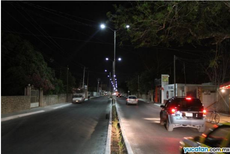
Postes de 12 metros a 35 metros de distancia interpostal, con dos carriles por vía Luminarias de 80W de inducción.
